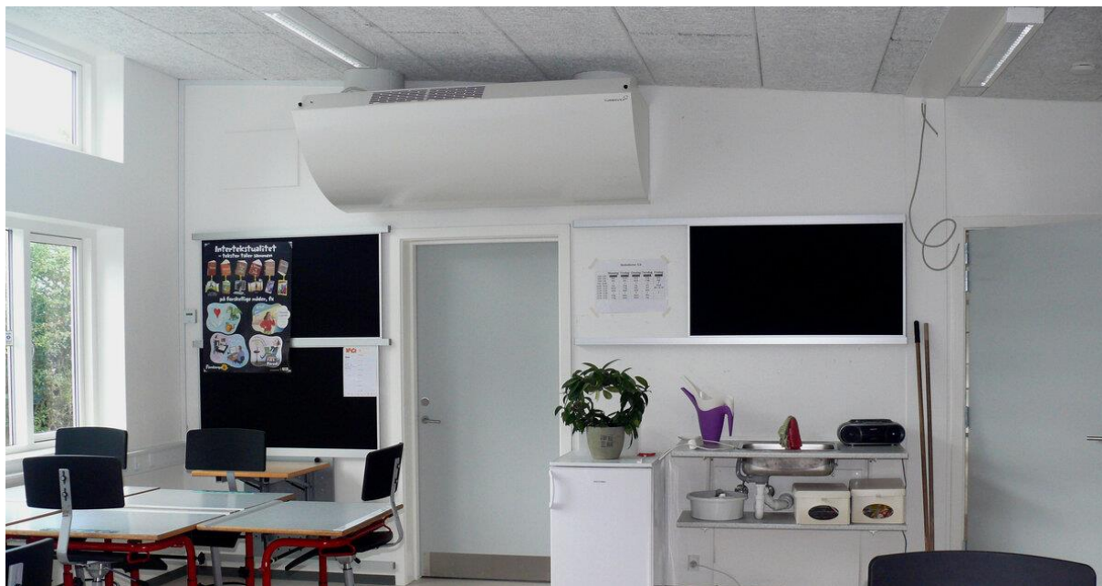
Obr. č. 3 příklad instalace rekuperační jednotky v místnosti
